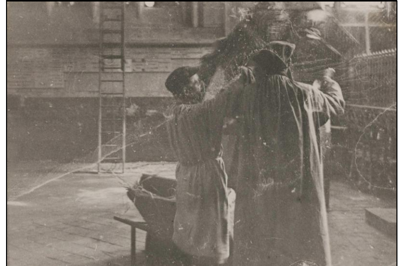
▲ Démontage des verrières de l'église Saint-Etienne de Beauvais le 6 avril 1918 en prévision des bombardements sur la ville (coll. BDIC).
